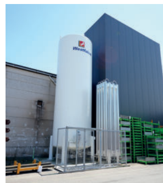
Резервуар объемом 41 куб.м. с азотом и автоматизированный склад Kardex для оснастки и небольших серий деталей
