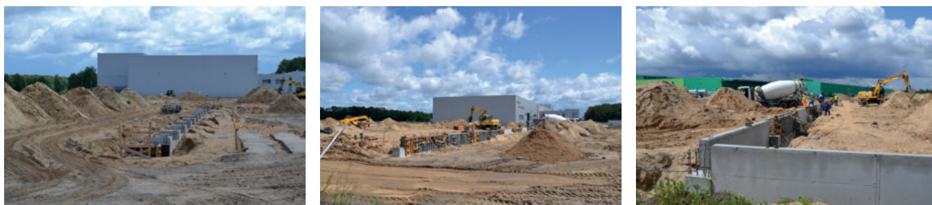
Текущие работы в Польше по строительству склада площадью 12 000 кв.м.
