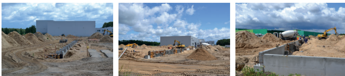
Laufende Arbeiten in Polen zum Bau einer 12 000 m 2 großen Lagerhalle
