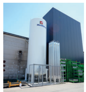
41 m 3 Stickstoffvorrat und automatischer Kardex-Lagerturm für Schablonen und Kleinserien von Teilen
