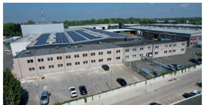
600 m 2 Erweiterung des Gebäudes, in dem die technischen und IT-Büros untergebracht sind
