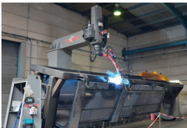
Kippermulde wird auf einer rotierenden Schablone befestigt und von einem Roboter geschweißt
