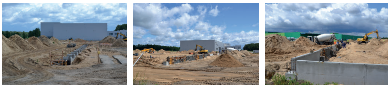
En Polonia se está construyendo una sala de almacenamiento de 12 000 m 2
