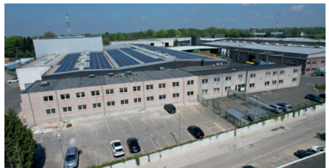
Ampliación de 600 m 2 del edificio que alberga las oficinas técnicas e informáticas
